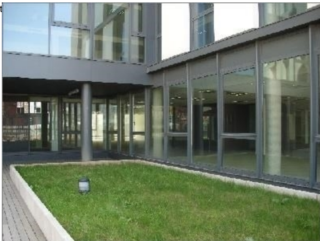
Photo du bâtiment en extérieur 2
